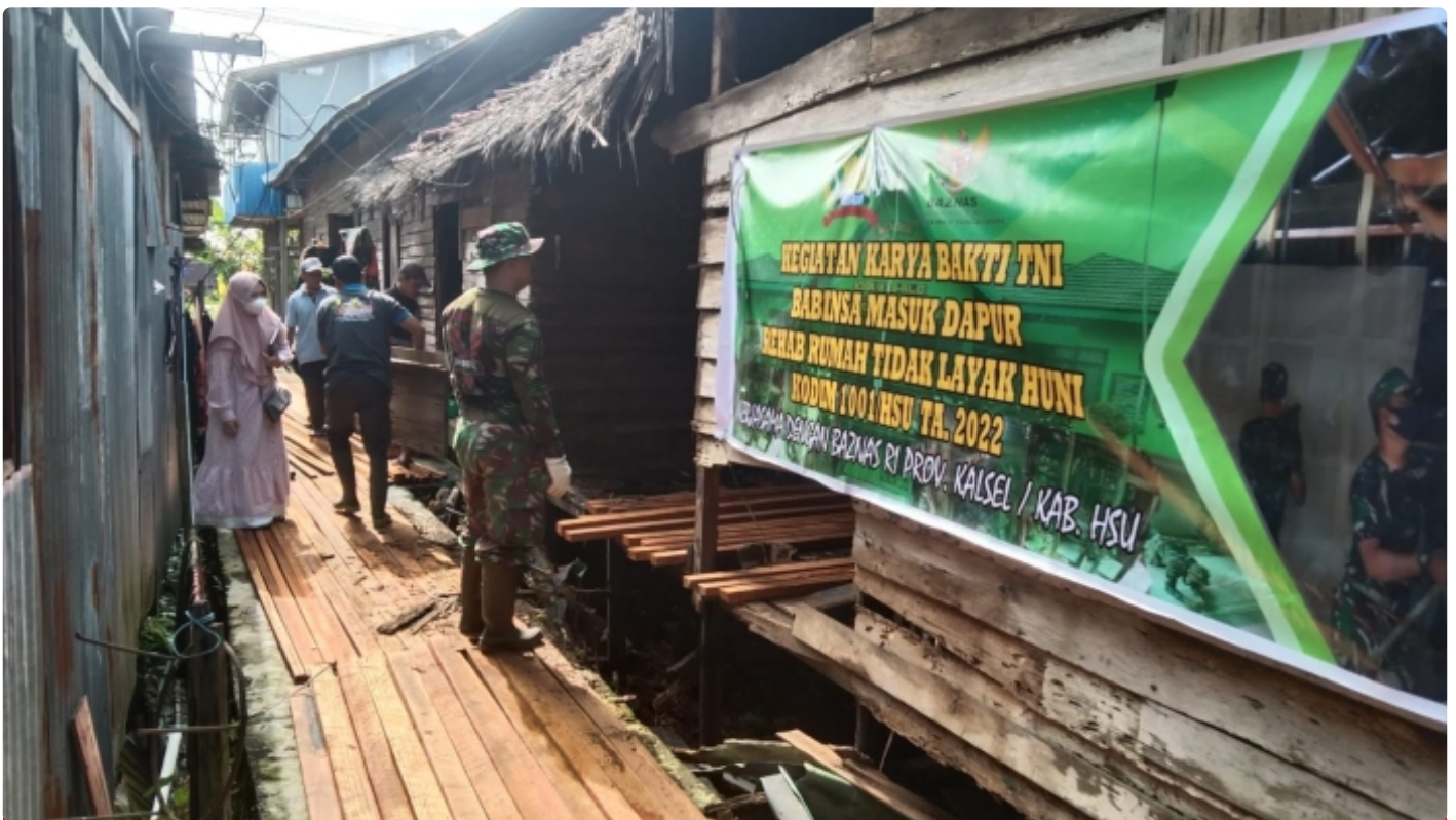
Kodim 1001/HSU-Balangan Bekerja Sama Dengan Baznas Rehab 10 Rumah Di Kab. HSU
